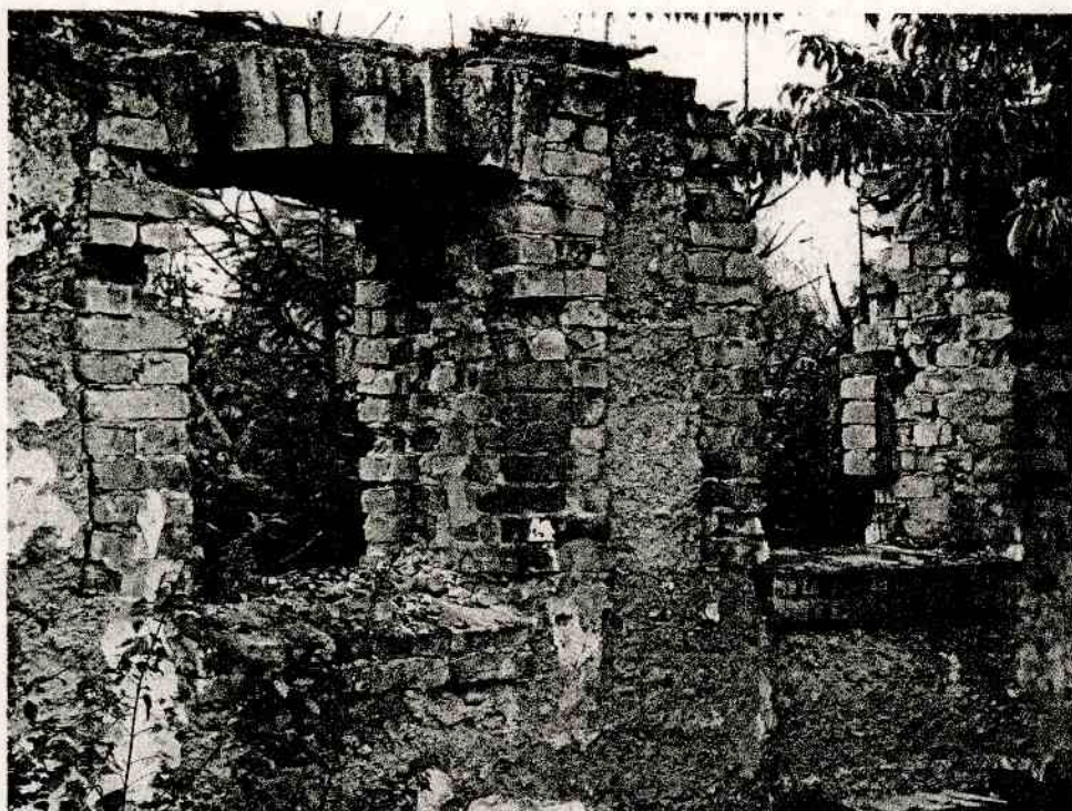
Pozostałe fragmenty budynku gospodarczego
